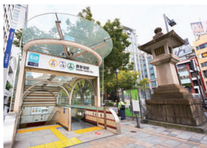
東京地下鉄株式会社 (東京メトロ 表参道駅)
